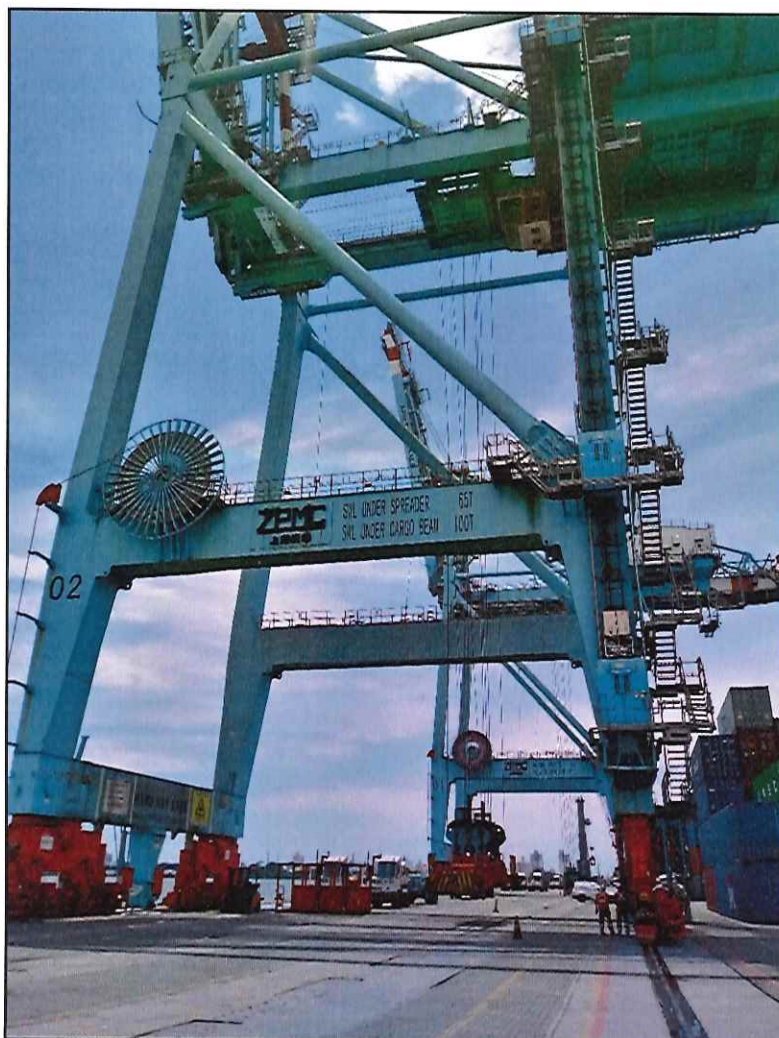
Figura 1. Guindaste de cais (portainer), STS-02.
